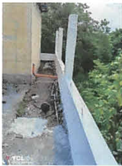
Foto 3: reforzamiento del muro perimetral
