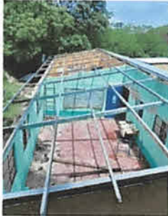
Foto1: Instalacion de la estructura metalica
