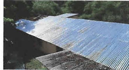
Foto 2: instalacion de lamina
